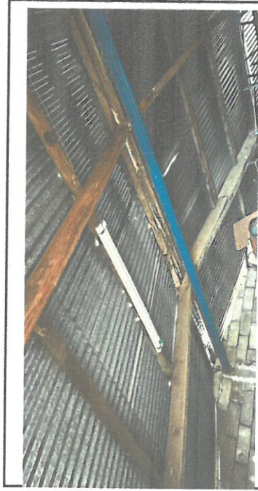
Foto 3: Suministro e instalación de portante de techo de aula.
